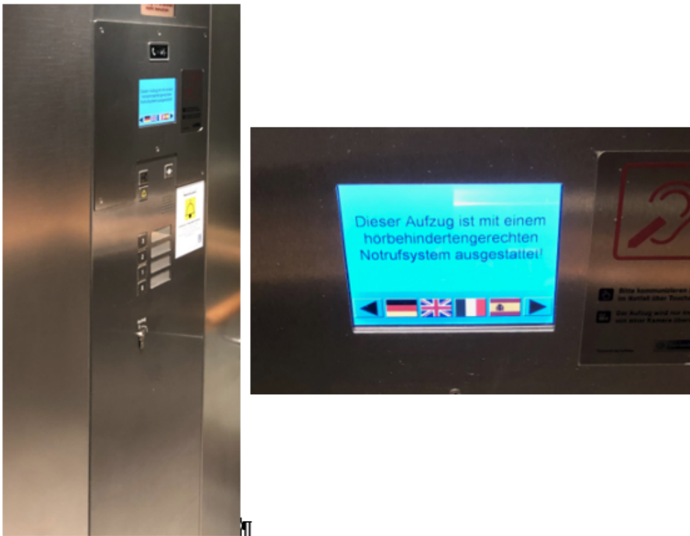
Abbildung 31: Visuelles Notrufsystem mit Touchscreen
