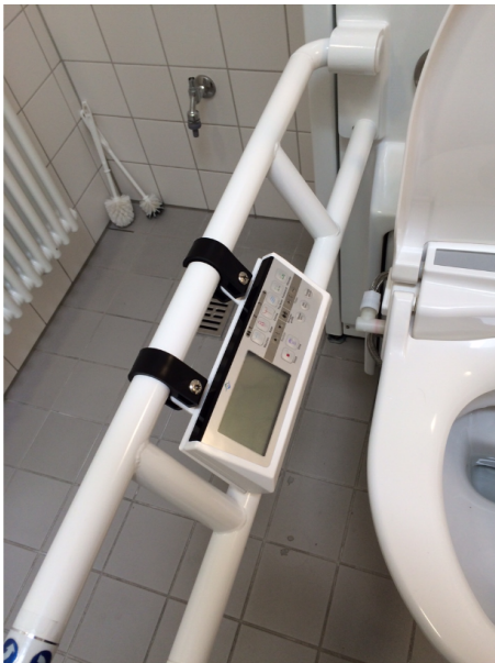
Abbildung 44: Fernbedienung des Dusch-WC am Stützklappgriff
