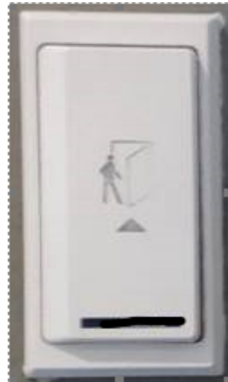
Abbildung 32: Beispiele für Türöffnungstaster als Flächentaster in den Oberlandesgerichten Düsseldorf und Köln
