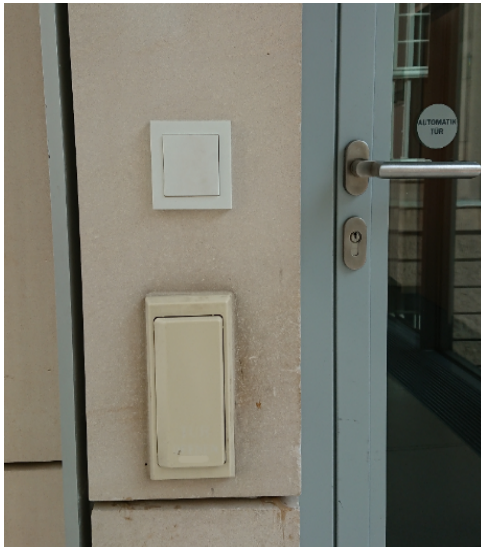
Abbildung 32: Beispiele für Türöffnungstaster als Flächentaster in den Oberlandesgerichten Düsseldorf und Köln
